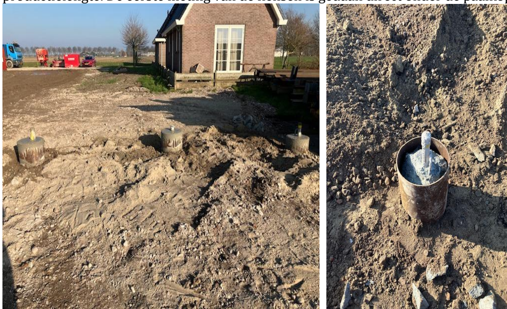
FIGUUR 13 OVERZICHT VAN DE PROEFPALEN IN OOSTWOUD VOOR EN NA HET AfstORTEN VAN DE CASINGS
